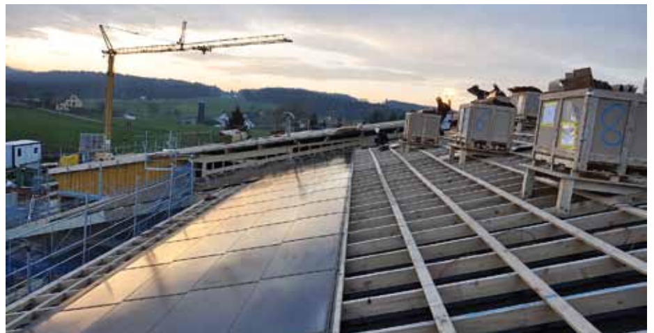
kabeltechnik swiss ag, Schinznach-Dorf, bei der Montage der Panels
