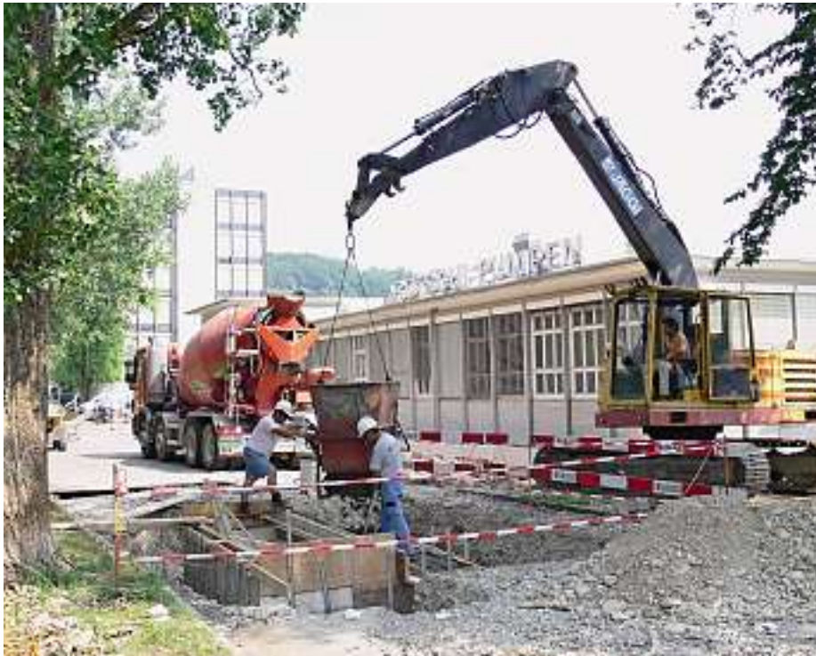
Der Kabelschacht der Trafostation Dammweg wurde mit Recyclingmaterial betoniert.
