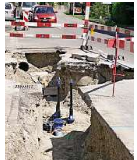
Baustellen – mühsam für viele, aber notwendig, um die Versorgungssicherheit zu gewährleisten.
