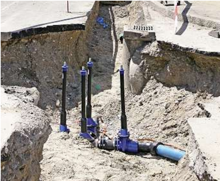
Grossprojekt Werkleitungserneuerung in Schinznach Dorf. Stand Ende Juni 30% oder 161 Meter. Im Vordergrund Armaturen in Hauptleitungen (4 Absperschieber und Schieberstangen).
